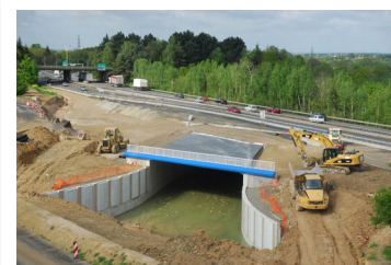
Ouvrage sous la rocade
