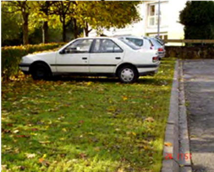
Parking engazonné perméable
