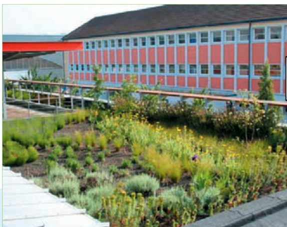
Toiture stockante végétalisée
