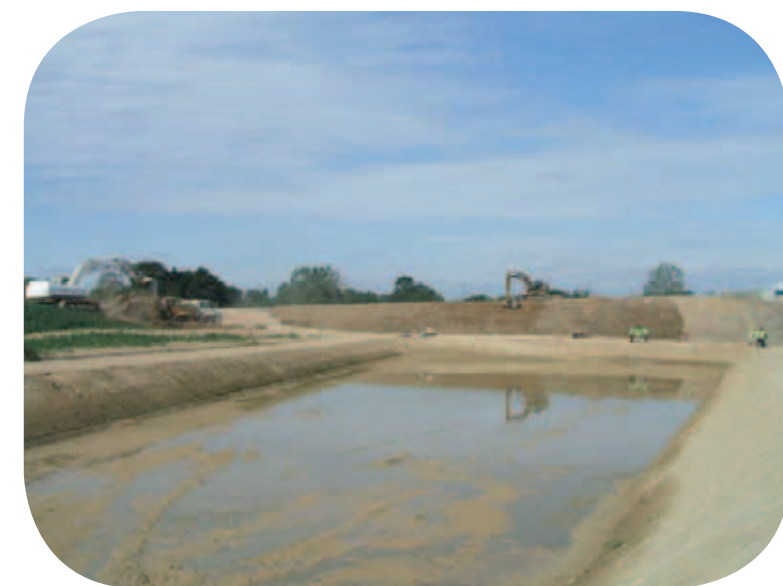
La réalisation du réseau d'assainissement et des bassins tampons en 2010.
