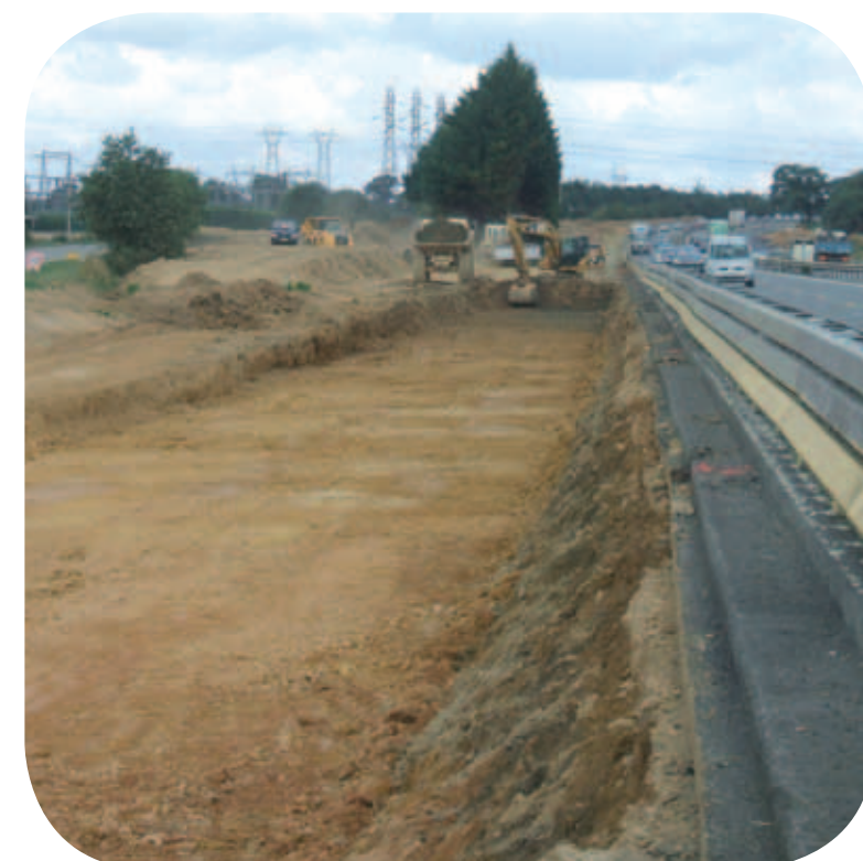
La modernisation de la RN12 : son élargissement à six voies et la modification de l'échangeur de Pacé en 2010.
