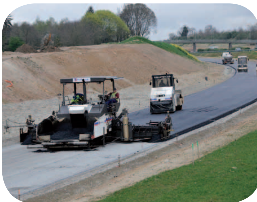
La construction de la nouvelle « quatre voies » et ses équipements en 2010 et 2011.
