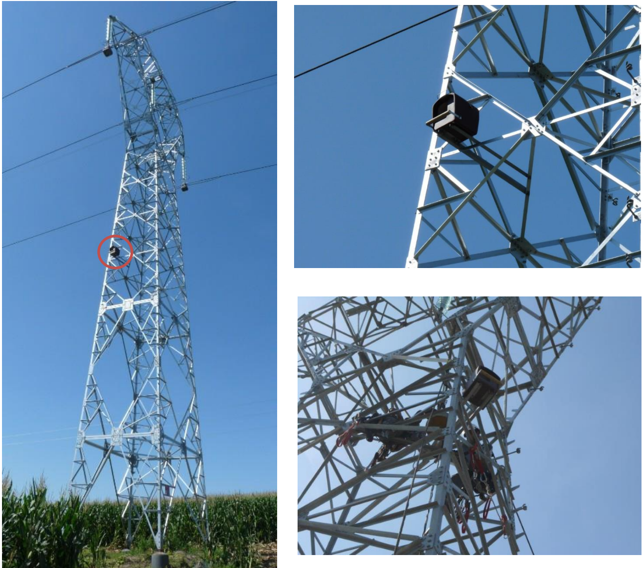
Figure 6 : Pose de nichoirs à Faucon crécerelle
