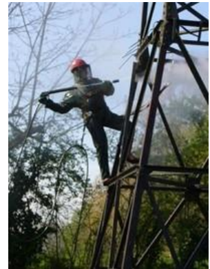
Figure 2 : Préparation des surfaces avant la mise en peinture
