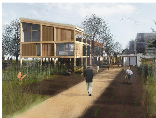
Les nouvelles constructions seront sur pilotis, et ce afin de dégager de l'espace au sol pour favoriser la biodiversité et limiter l'artificialisation du sol. Ce système favorise aussi l'adaptation à la topographie et permet d'adapter la jonction entre logements.
