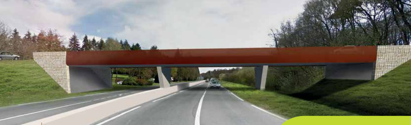
Le pont de la RD1 - PS2
