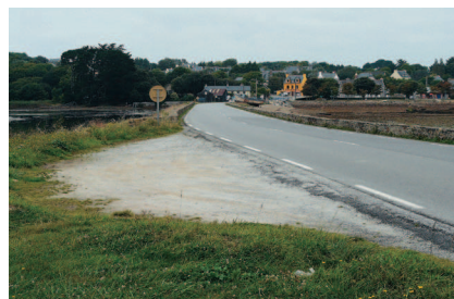
▲ La route départementale n° 55 a été aménagée sur la digue isolant l'étang du Fret du milieu marin.
