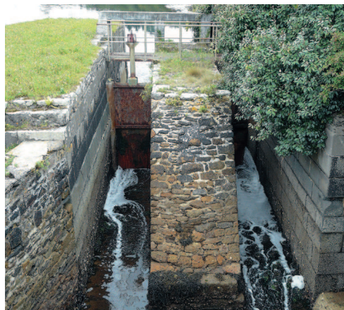
▲ L'ouvrage de vidange de l'étang, vestige de la présence d'un ancien moulin à marée au XVIII e siècle.
