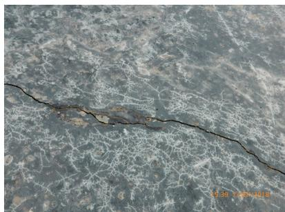
**Dégradation du joint entre panneaux préfabriqués**
