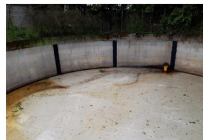
*Exemple de travaux sur une fosse : dalle de ragréage et joints entre les panneaux préfabriqués*
