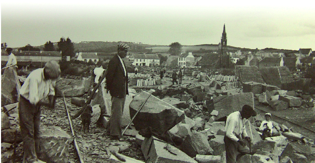
Photo ancienne de la carrière du Run en exploitation.
