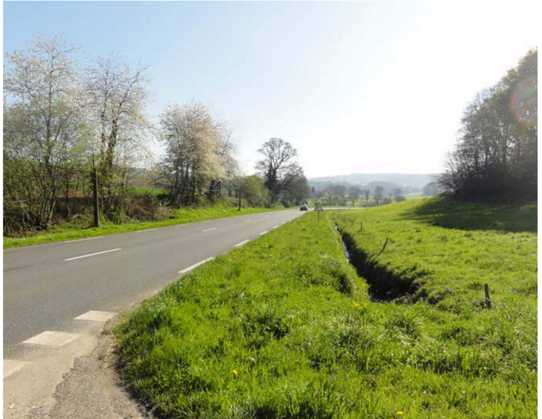
Mûr-de-Bretagne - RN 164 - Thalweg de Le Rossuliet
