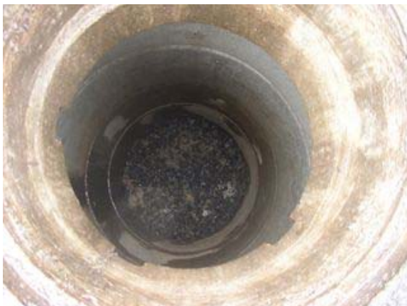
Figure 24 : Puits d'infiltration - Noue
