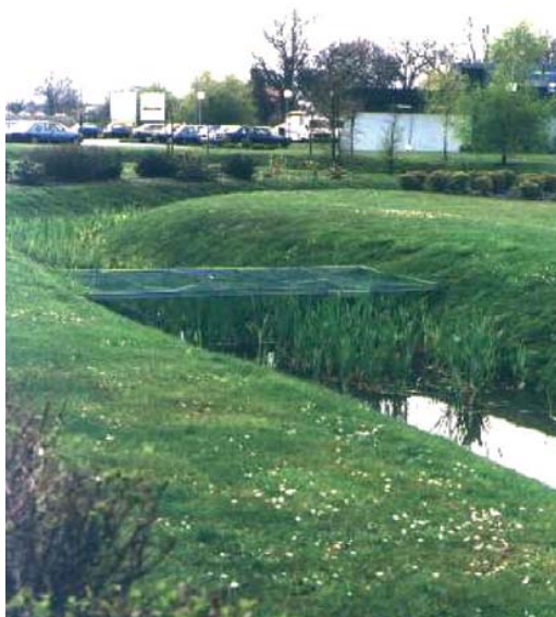
Figure 26 : Fossé de rétention
