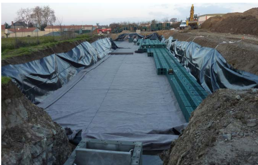
Figure 25 : Bassin enterré sous chaussée
