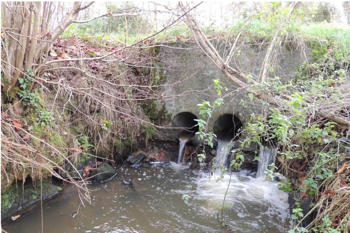
Figure 20 : Exutoire 14, trois buses de traversée.
