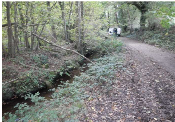
Vue de la partie aval
