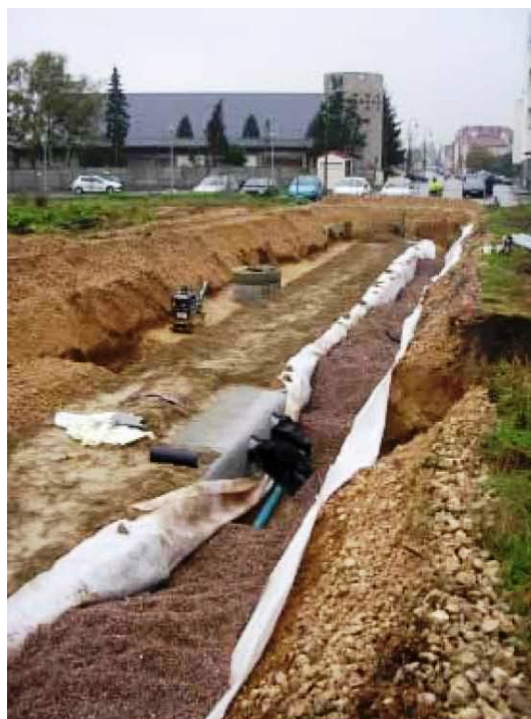
Remblaiement de la structure
