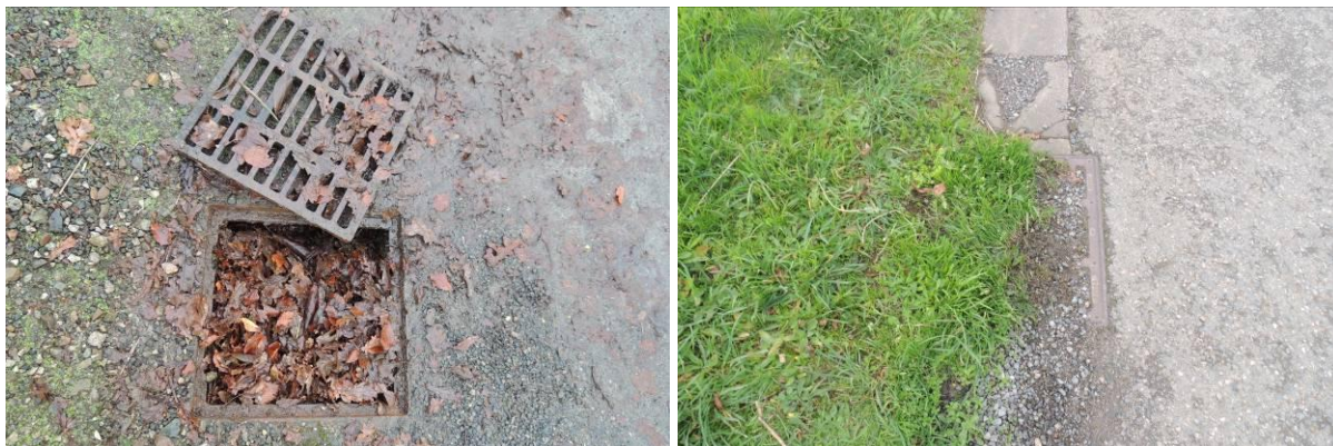
Figure 54 : Exemples de grilles colmatées bassin versant 14 et 5 et zone de Kerbiquet
