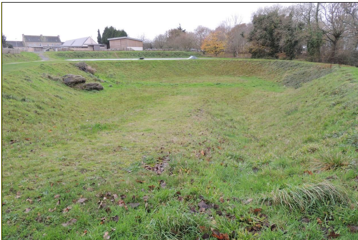
Figure 5 : Bassin tampon du Bourg.
