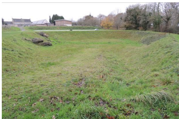
Figure 13 : Exutoire Bassin tampon
