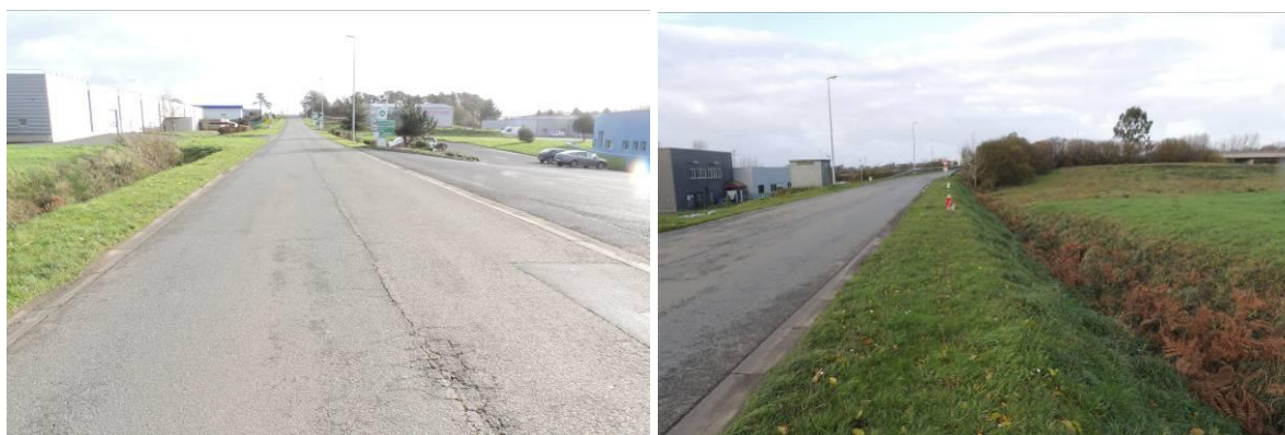
Figure 33 : Caniveaux CC1 sur chaussée
