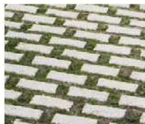
Pavage en béton avec ouvertures de drainage
