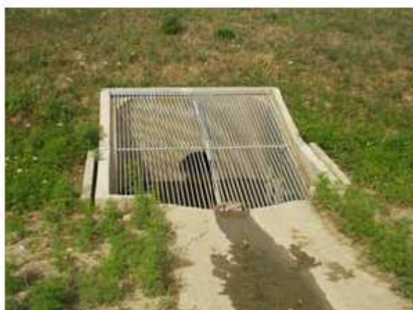
Grille de protection sur ouvrage de sortie
