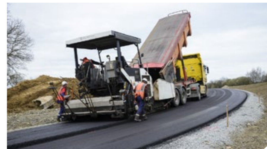
Mise en œuvre des enrobés sur la bretelle de sortie de Launay Grésillon
