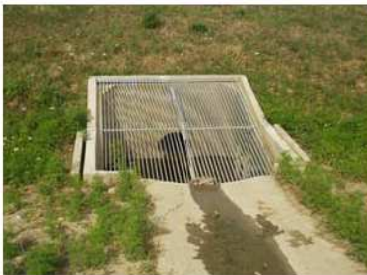
Grille de protection sur ouvrage de sortie
