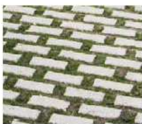
Pavage en béton avec ouvertures de drainage
