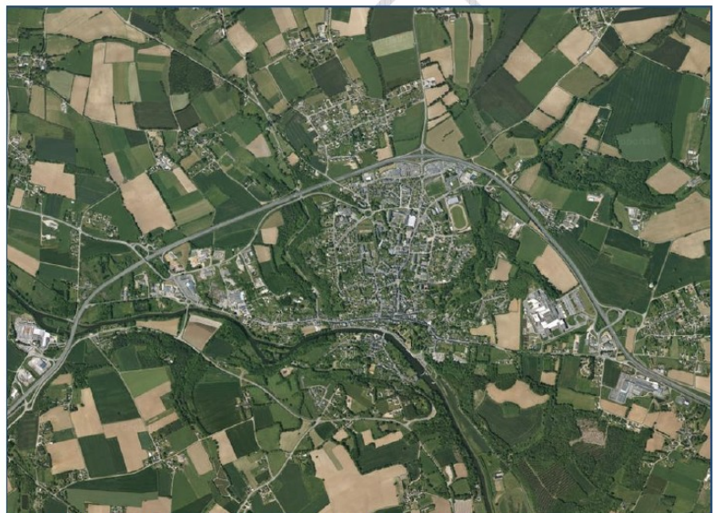
Localisation de la commune de Josselin et photographie aérienne de la trame urbaine communale. Source : Géoportail
