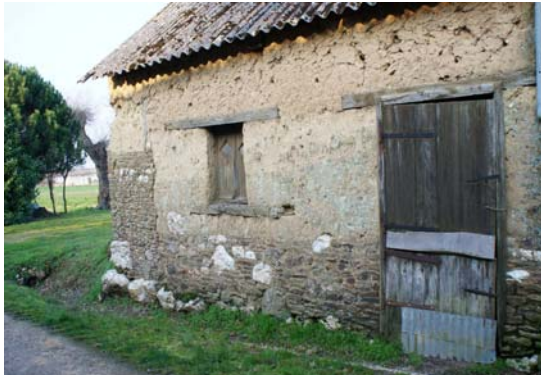
Bâti modeste en terre
