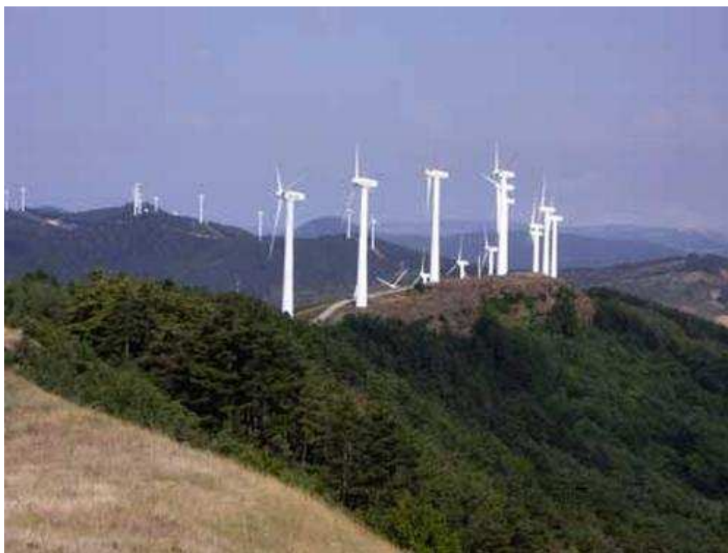
Parc éolien de Pamplune, Espagne (photo : Yves Gagnon)
