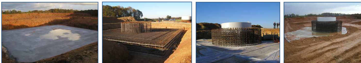
Chantier parc de la Butte des Fraus. Mohon : coulage du béton dans les parcelles
