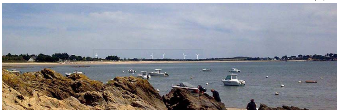
Parc éolien de Muzillac (56)
