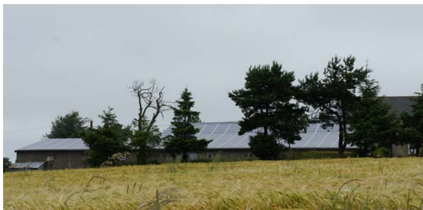
Ferme équipée de panneaux solaires
