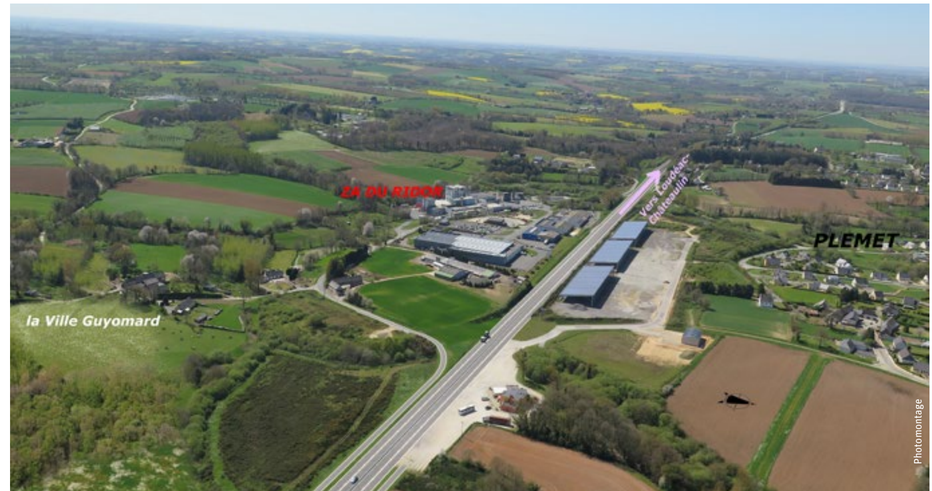
Variante aménagement sur place : Zone Artisanale du Ridor
