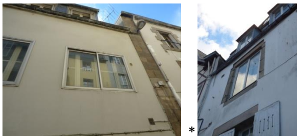
A EVITER – la double fenêtre extérieure
