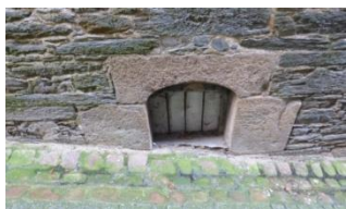
Ouverture de cave obstruée
