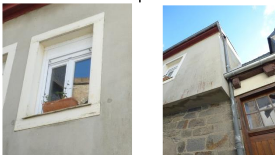
A EVITER – modification de la profondeur des ouvertures et l'accentuation du débord sur rue
