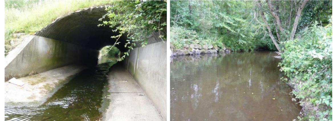
Dans la buse, une série de petits plots en béton sont implantés en biais sur le radier. Il est difficile d'imaginer leur origine et le rôle qu'ils sont supposés jouer.
