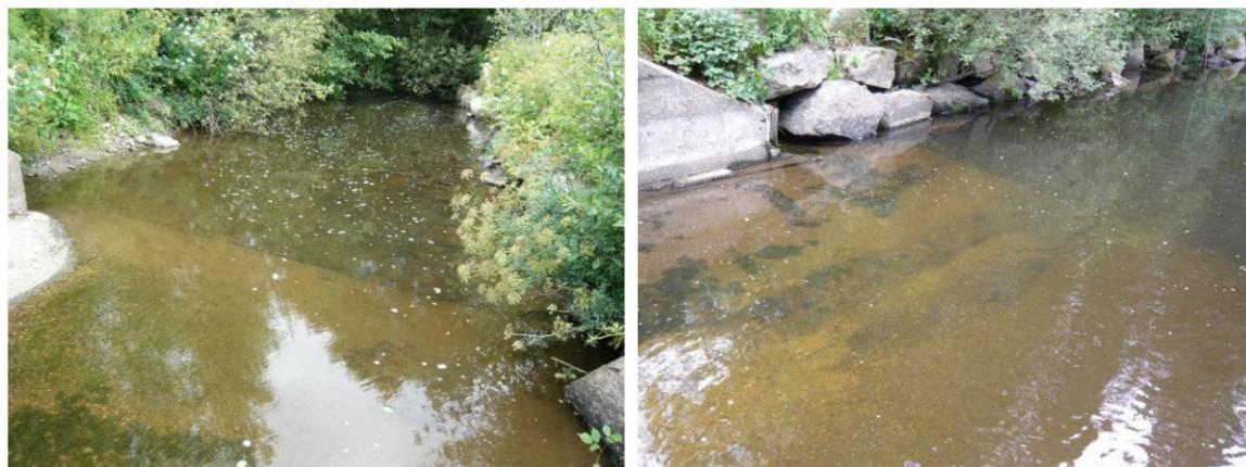
En amont, après l'entonnement, le profil arrondi du radier de la buse concentre le débit le jour de la visite sur une largeur d'environ 1,50 m, avec une hauteur d'eau maximale de 10 cm. Le courant est moyennement fort. (photo ci-dessous à gauche)
