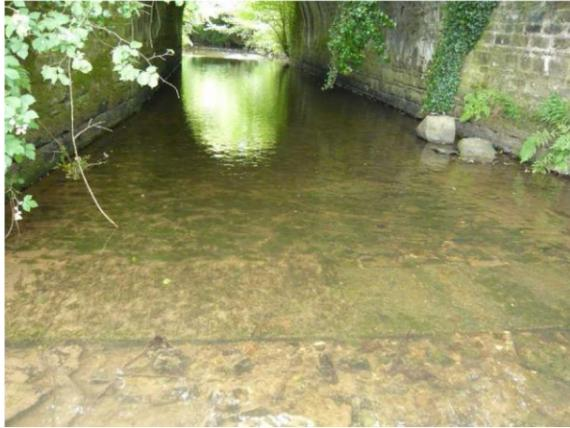
A l'aval, ce seuil constitue un dénivelé d'environ 15 cm au-dessus du substrat du lit, constitué de galets. Le jour de l'observation, la lame d'eau était d'environ 5 cm.
