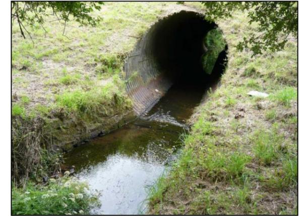
A l'extrémité aval de la buse, il existe une chute d'environ 20 cm entre le radier et le niveau aval dans la « fosse » en pied du talus routier.
