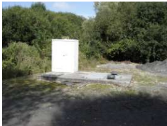
Photo 1 : Poste de refoulement de Pontanézen
