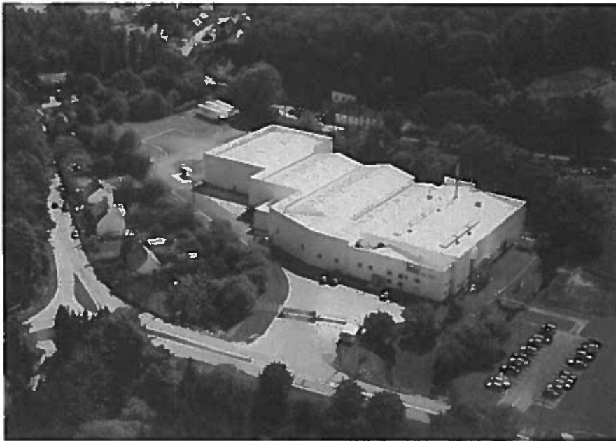
Vue aérienne du site (extrait de l'étude hydraulique en annexe 4)
