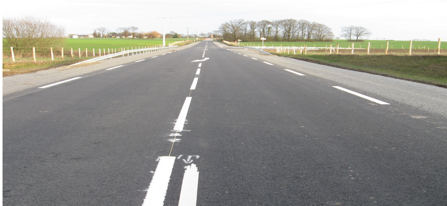
La voie nouvelle
