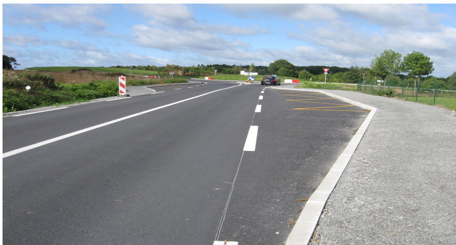
Les nouveaux arrêts de bus sur la RD48 et le giratoire
