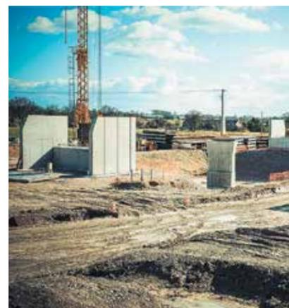
**5 Réalisation du Passage Inférieur du ruisseau du Garun : mise en service prévue pour la fin 2015.** La future 2x2 voies doit franchir le Garun, passant sous chacune des bretelles de raccordement à la RN12. Pour réaliser ces ouvrages d'art, le cours du Garun a été dévié sur une centaine de mètres fin décembre 2014. Une pêche de sauvegarde préalable a eu lieu pour capturer les poissons et les déverser en aval des travaux.
