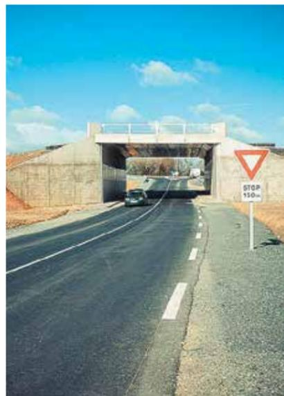
**2 Rétablissement de la Voie Communale (VC) 13 : mise en service prévue au printemps 2015.** Construction d'un passage supérieur au-dessus de la future 2x2 voies et d'un boviduc sous la VC13.
