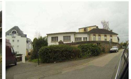
Au sud de l'enclos, marqué par une forte dénivellation, une partie du bâti peut être démolie pour lier la rue des Tilleuls au cœur de l'îlot. Le bâti à encadrement de baies en briques, à droite, peut être maintenu.
