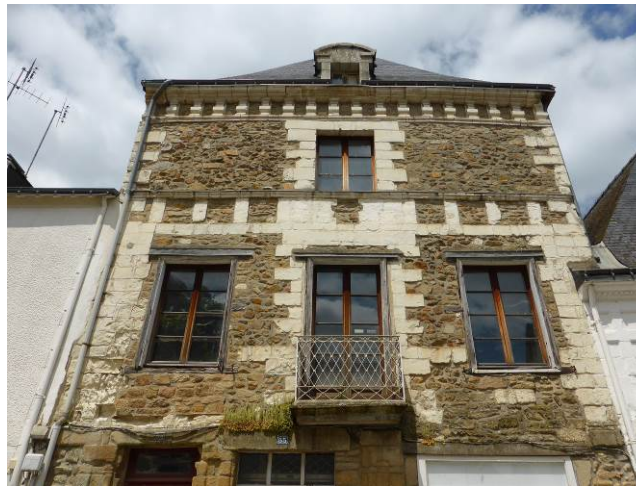
Pierre calcaire (tuffeau) de couleur blanche. Le moellonnage en granite était destiné à être enduit. Maison rue du Château.
