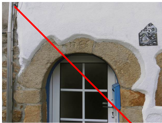
Ci-contre, l'enduit a été appliqué en épaisseur et présente un fort relief par rapport au nu de la pierre apparente.
