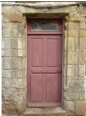
Rue du Château - Porte à planches dans un cadre
