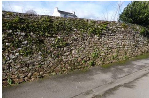
Mur plein, moellonné, toute hauteur (2,20 à 2,50 m)
