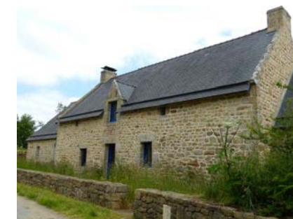
Maison à Keropert.
