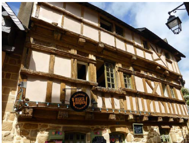
Rue Saint-René, Saint-Goustan
