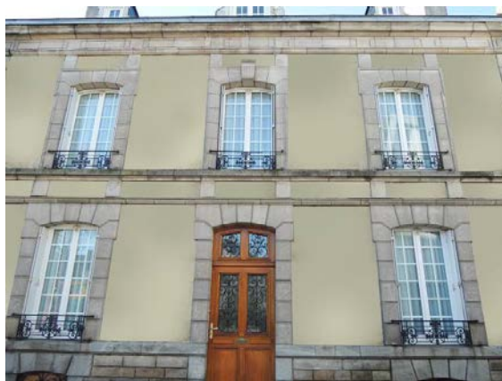
APRES : mise en valeur de la pierre de taille noble des encadrements, des bandeaux et du soubassement : OUI (simulation)
