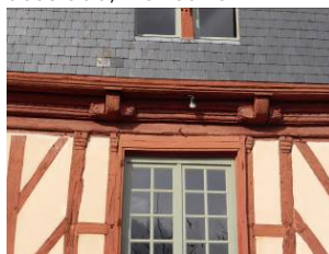
Linteau en « T » orné d'un arc en accolade, Kerléano
