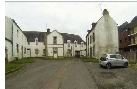
Façade arrière de l'Hôtel-Dieu, ouverte sur une large courée ; la maison à droite, postérieure a l'intérêt d'éviter une vue directe sur le long front bâti sur l'immeuble moderne de la rue Pasteur
