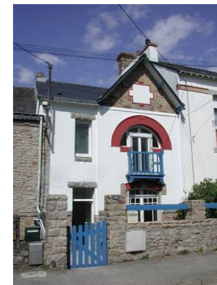
Lotissement du Chemin noir. Rue Jean Jaurès.
