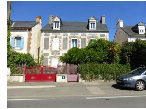
Avenue du Général de Gaulle (Vo)
