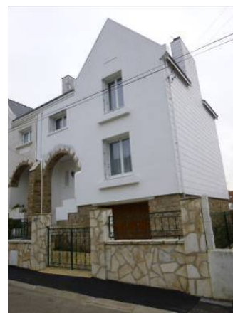
Quartier de Kerdrain. Rue Sombreuil.
